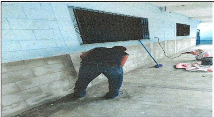
Foto 3: Reparacion de repello y cernido en muro de mamposteria con aplicación de acabado uniforme
